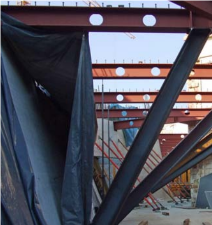
▲ Bauzustand Absteifung außen und innen Fotos: GSE
